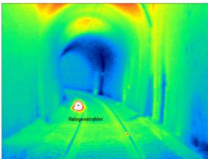
Ansicht: Übergang Stahlbetonbrücke / Felsmauerwerksgewölbe (Blickrichtung: West)
