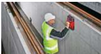
Messung an einer Kranbahn
