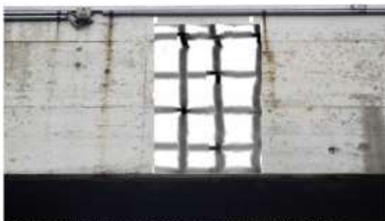
Aufnahme: Lage der äusseren, schiefen Bewehrungsstäbe in der Mitte, Frontseite
