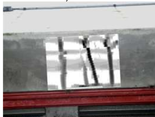
Aufnahme: Lage der äusseren, schiefen Bewehrungsstäbe in der Mitte, Unterseite
