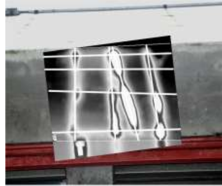
Aufnahme: Lage der äusseren, schlaffen Bewehrungsstäbe in der Mitte , Unterseite
