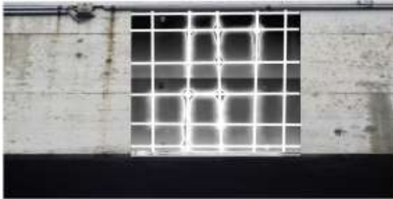
Aufnahme: Lage der äusseren, schlaffen Bewehrungsstäbe in der Mitte , Frontseite
