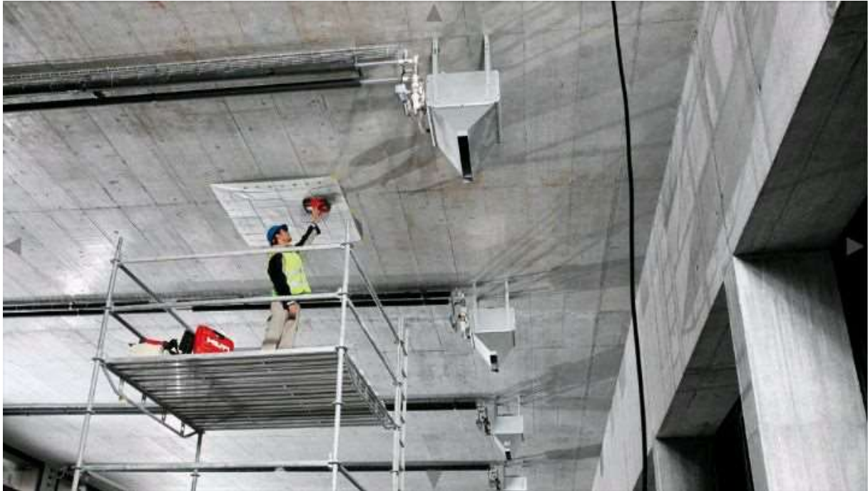
Aufnahme 3: Einsatz unter einer Brücke
