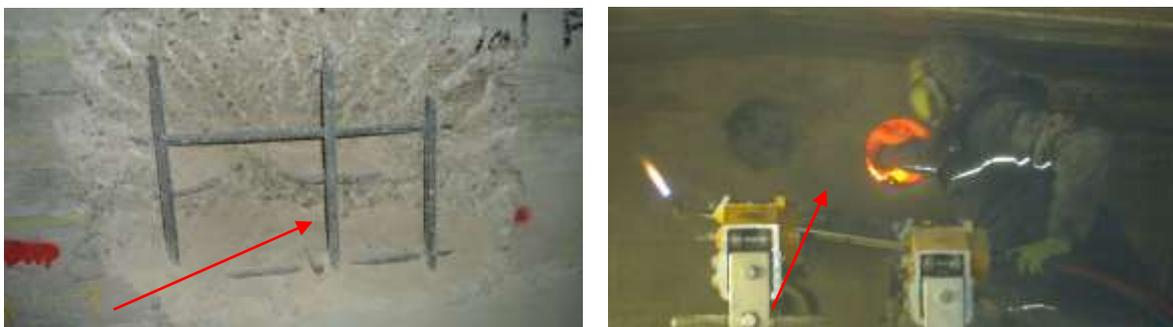
Weil unbekannt ist, wo die Spannkabel im Beton verlaufen und wie diese eingebaut sind, ist das Bauteil- und Bauwerksscanning immer dann angebracht, wenn ein Schaden unbedingt vermieden werden muss. Es werden nur Bohrungen oder Teilstücke von Bohrungen auf einer klaren Datenlage zur Ausführung freigegeben.
