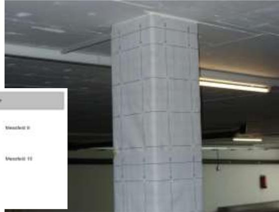
Aus den gemessenen Daten wurde die folgende Skizze erstellt. Die Bewehrung auf der Oberseite und auf der Unterseite der Decke ist in einem Raster von 20 cm x 20 cm verlegt. Ein Bewehrungskorb im Raster von 65 cm x 65 cm ist symmetrisch um die Stütze einbetoniert. Im Stützenbereich konnten keine Anschlusseisen festgestellt werden.
