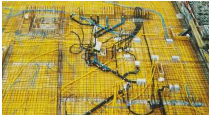
Nicht nur im Innenbereich (Bild rechts) stellen im Beton verlegte Leitungen, Kabel oder Einbauten eine besondere Herausforderung dar, auch beim grabenlosen Verlegen von Leitungen oder beim Verlegen von Bohrungen unter einer Strasse oder einem Weg hindurch, stellen sich solche Probleme (Bild links).
