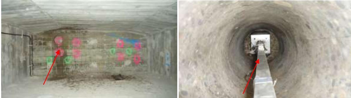
Die folgenden Bilder zeigen, was in der realen Situation immer wieder vorkommt. Bild rechts zeigt die Situation, wo ein Bewehrungsstab so in Richtung des Bohrkerns gelegen hat, dass der Beton mit einem Spitzhammer aus der Tiefe herausgebrochen und der Bewehrungsstab mit einem Brenner entfernt werden musste. Bild links zeigt die effektive Bewehrungslage die vor dem Bereich der Spannkabel eingebaut ist.
