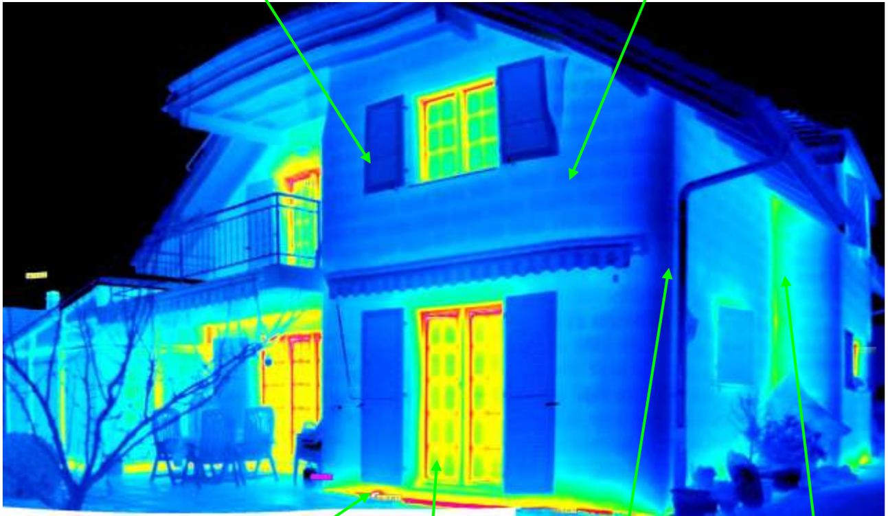
Sockel des Gebäudes. (Vielfach in Stahlbeton ohne Isolation ausgeführt)
