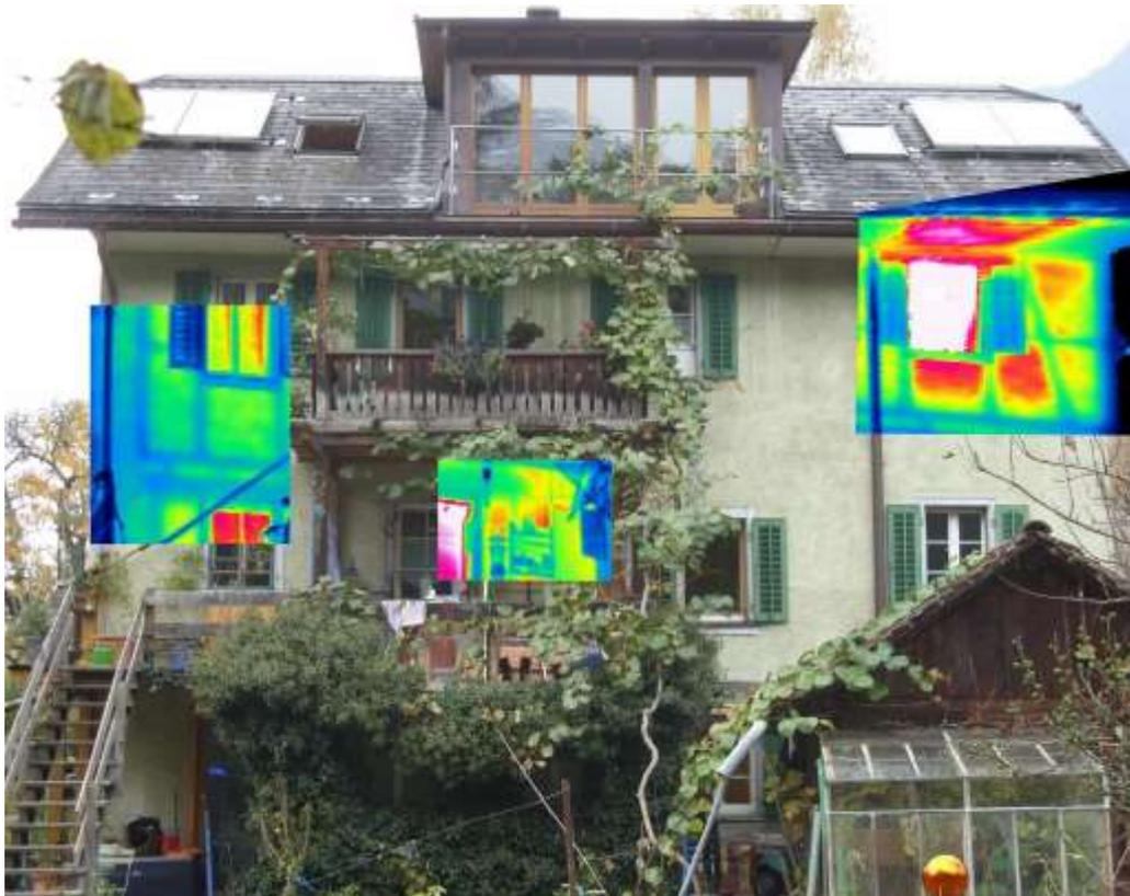
Die Thermografie wird in der Regel gezielt eingesetzt, um noch offene Fragen, die sich aus der Gebäudeanalyse ergeben, zu klären oder um einen Nachweis über die Qualität ausgeführter Arbeiten am Objekt zu erbringen.
